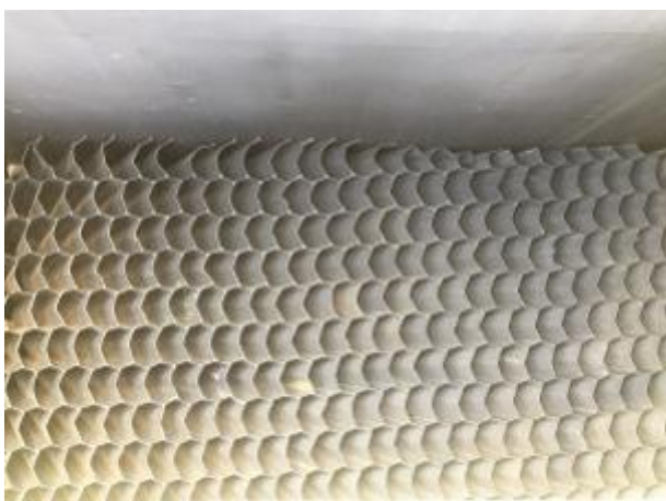
Foto 07 – Decantador Secund. (Lamelas ok)
