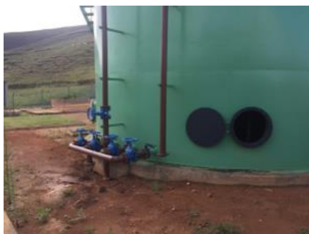
Foto 08 – Tubulação de Descarte de Lodo UASB
