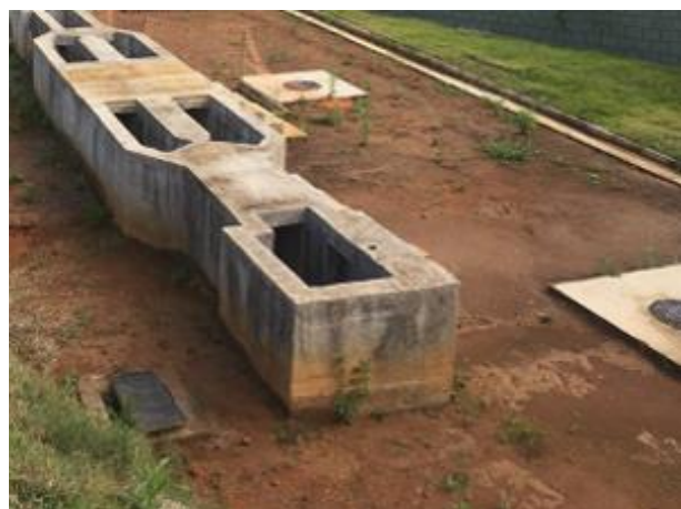
Foto 01 – Caixa de Areia / Gradeamento
