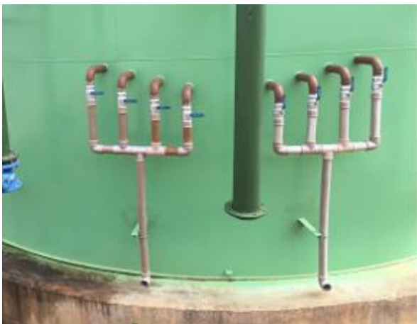
Foto 09 – Tubulação de Coleta de Amostras
