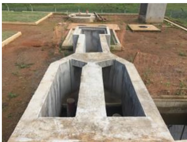
Foto 02 – Caixa de Areia / Gradeamento
